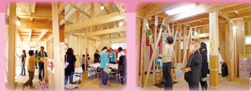
工事中見学会の様子
