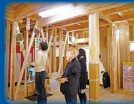
工事中見学会の様子
