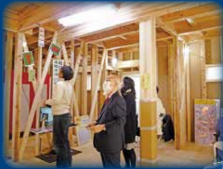
工事中見学会の様子
